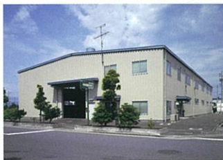
▲平成2年当時の旧横浜配送センター
