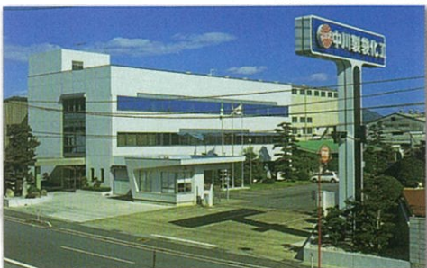
▼平成6年 現本社ビル完成
